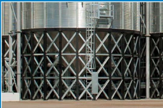
Опорные конструкции (поставляемые с бункером) обеспечивают высокое положение модуля для легкого доступа для установки транспортного оборудования.
